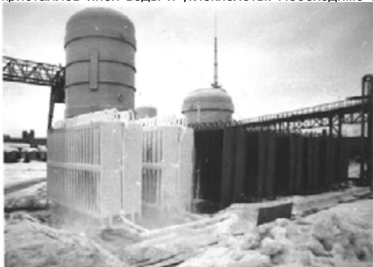
Рис. 1. Испытания панельного испарителя атмосферного газификатора на обмерзание инеем, февраль 1989 г.
